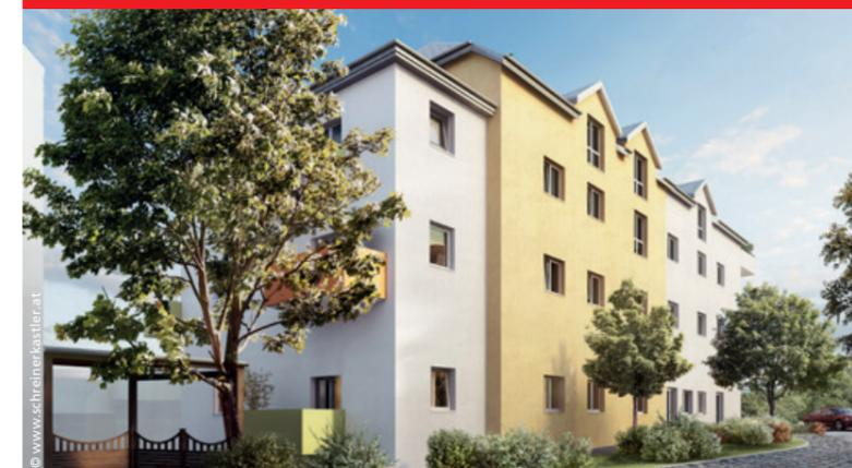
**Payerbach, Ortsplatz 3:** Die Gewog „Arthur Krupp“ modernisiert und wertet ein Gebäude aus dem Jahr 1909 ökologisch auf. Dies betrifft sowohl den Wärmeschutz, als auch die Haustechnik, die mit einer Fußbodenheizung per Luft-Wasser-Wärmepumpe und einer Photovoltaikanlage (HWB ca. 22,9 kWh/m<sup>2</sup>a, fGEE 0,72) versehen wird. Das Projekt umfasst 22 geförderte, teils barrierefreie Wohnungen von ca. 35 bis 84 m<sup>2</sup> mit 2 bis 4 Zimmern sowie eine Arztpraxis.
